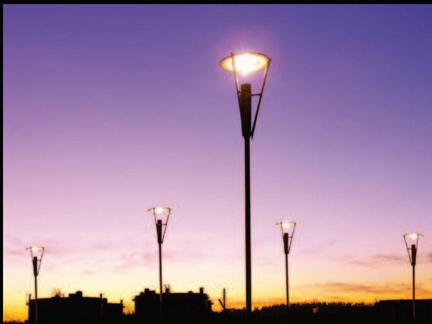
■ Installazione testa Tret Sky su palo Ø 80 altezza 6 metri. Installing Tret Sky head on Ø 80 column 6 meters height.
